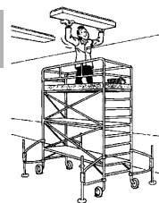
Un échafaudage roulant doit être stable pour éviter tout risque de chute
